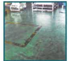
工場の床や壁
